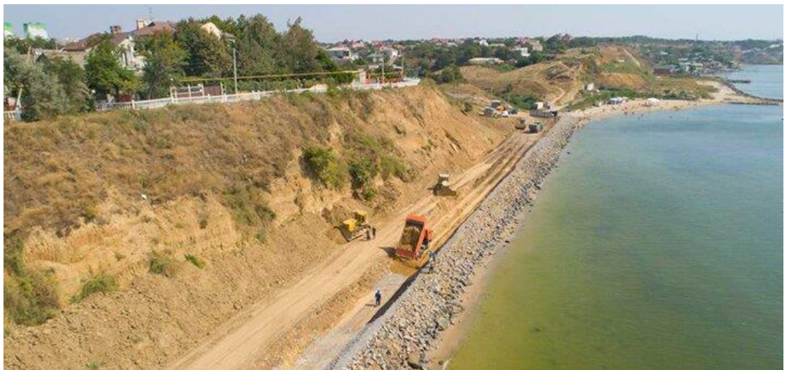
Рис 1.3 с. Крижанівка. Укріплення відкосів берега природним каменем
