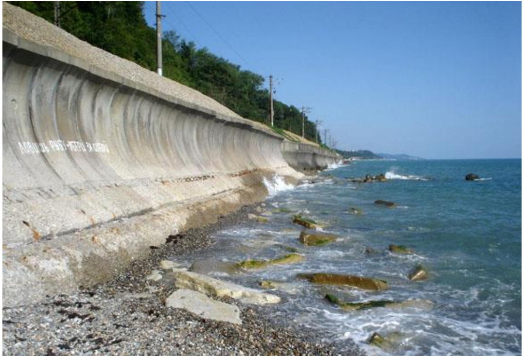
Рис 1.1 Південь півострова Крим. Волнозахисна стіна
