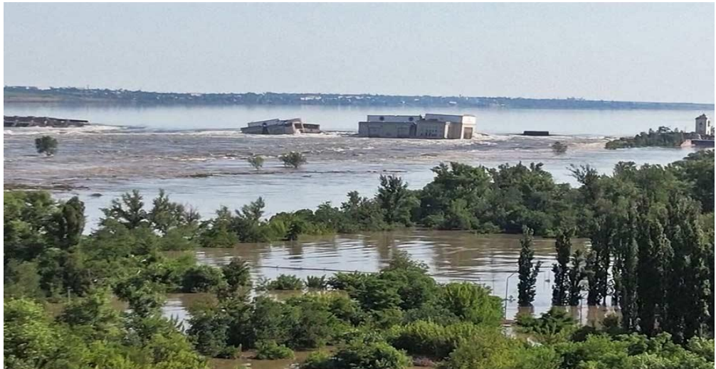
Рис.2.1. Вид на греблю Каховського водосховища сразу після підриву ворогами
