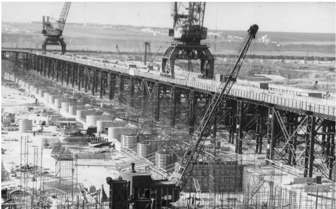
Рис.1.3. Будівництво греблі Каховського гідровузла 1954 рік
